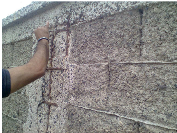
Fig. 10: Cls degradato
