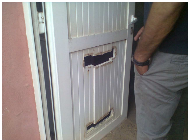
Fig. 6: Infisso locale deposito
